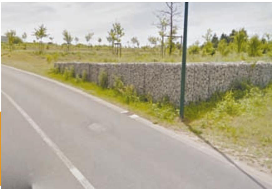
*Traitement d'un mur de soutènement de la zone d'activités à Vineuil (41) : réalisation d'un gabion en calcaire permettant une bonne intégration de la paroi dans le paysage.*
